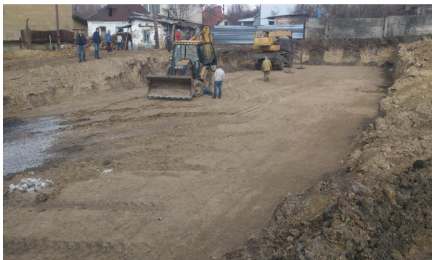
Рис. 5. Загальний вигляд котловану на вулиці Телевізійній після облаштування ґрунтової подушки фундаментної плити
